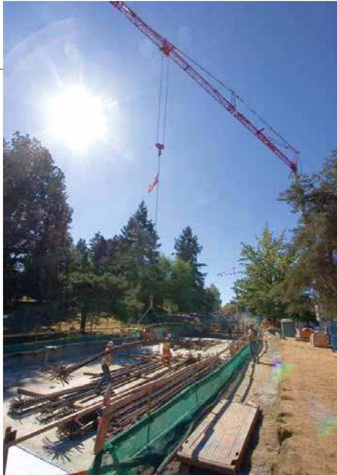
La possibilità di evitare di toccare gli alberi presenti nell'area è stata vitale per l'esecuzione dei lavori.
